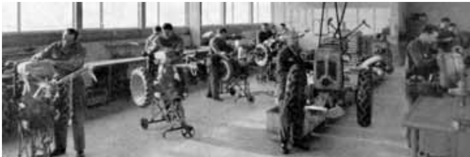
Neu eingerichtete Reparaturabteilung.
