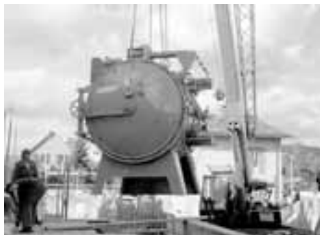
Neubau Vakuum-Halle in Urdorf (1982).
