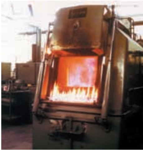
Moderne Schutzgasanlage im Betrieb Fällanden.
