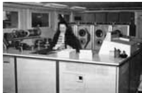
Der Rapid-EDV-Systemraum mit der Univac 9300 (1972).
