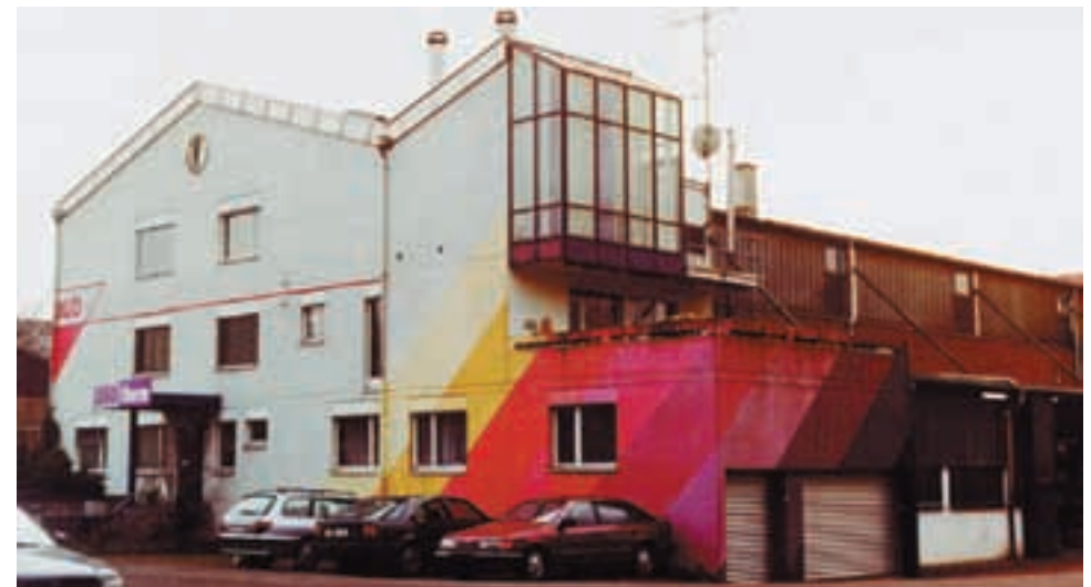
Nordwest-Fassade des Fabrikgebäudes in Fällanden (1975).
