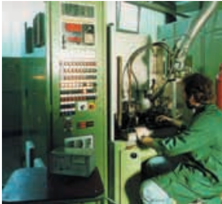
CNC-Induktionshärteanlage, Hochfrequenzgenerator 40 kW, Schaltsteller-Automatik.
