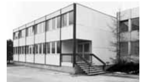
Im Anbau (1972) sind die Verkaufsabteilungen untergebracht.
