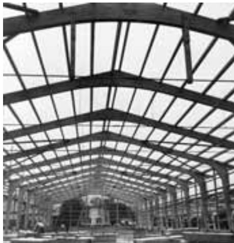
Holzkonstruktion der Lagerhalle.
