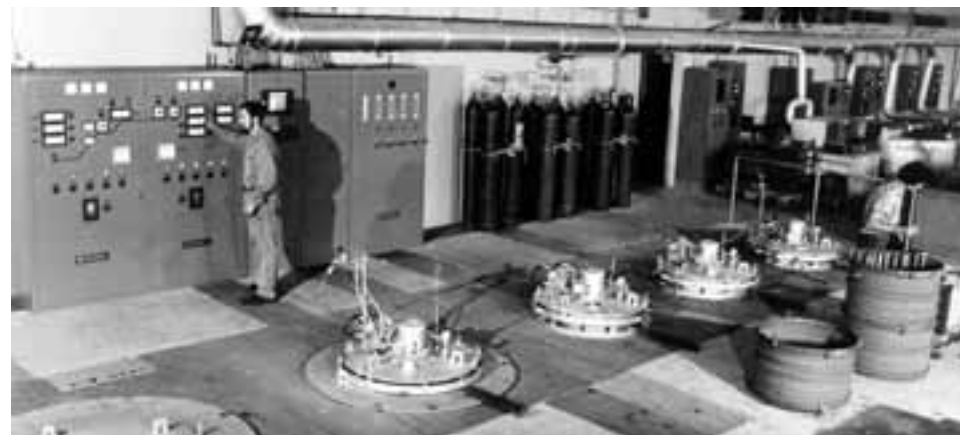
Vertikal-Retorten-Gasaufkohlungsanlage in Urdorf.
